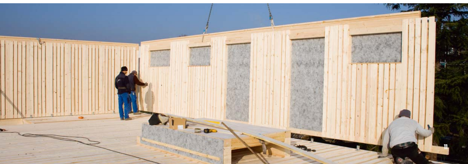
Les composants bois sont fabriqués en usine et assemblés sur place, en filière sèche, avec très peu de personnel et d'outillage - Photo: © Régis Mury
