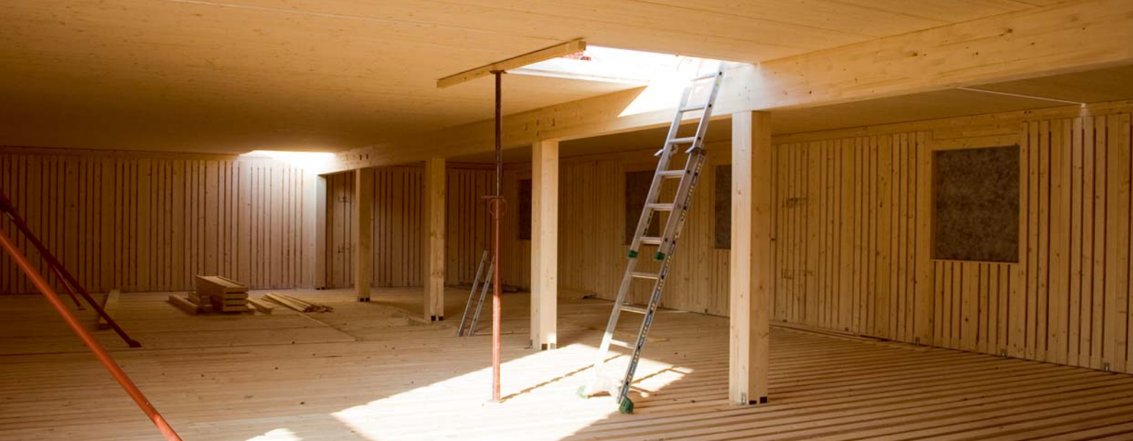
L'intérieur du bâtiment sud, plus précisément le premier étage, monté en deux jours - Photo: © Régis Mury
