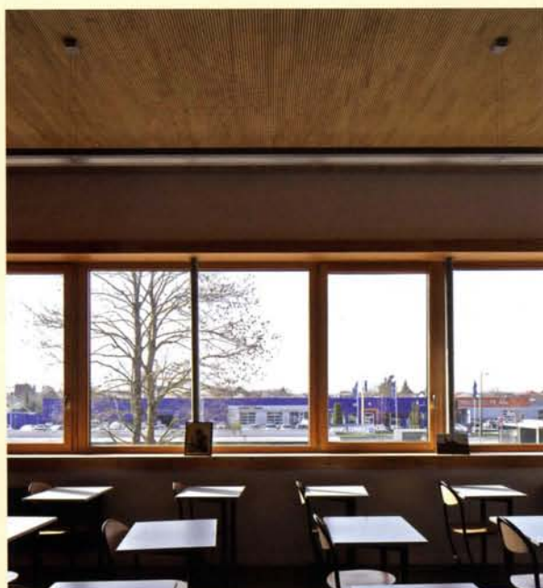
▲ Dans les salles de classe, le plafond acoustique bois atténue la luminosité d'une pièce largement vitrée.
