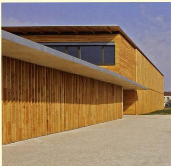
▲ Les façades sont intégralement bardées de lames de mélèze à pose verticale ou horizontale suivant la situation.
