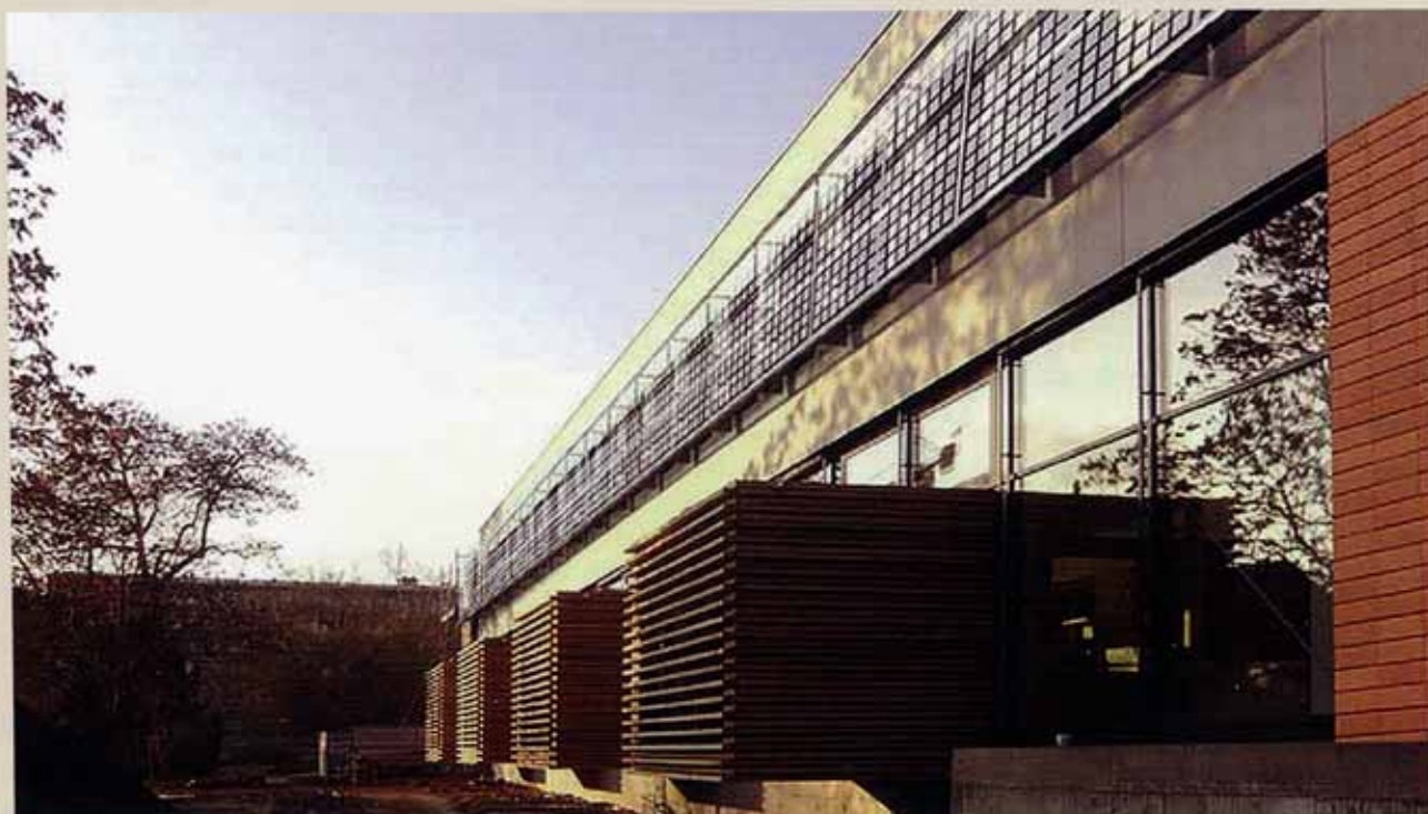
▲ La façade sud du centre de ressources est équipée de panneaux photovoltaïques qui servent aussi de brise-soleil.
