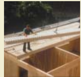
Assemblage sur chantier Eléments de Dalles LIGNOTREND
